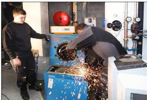
*Eine ausgediente Ölheizung wird demontiert ...*
