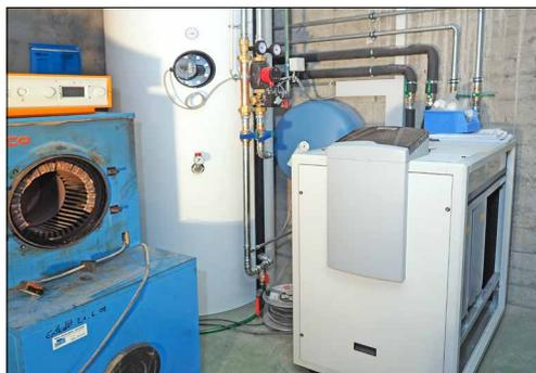
*Alt und Neu: die ausgediente Ölheizung und die Wärmepumpenheizung mit Kombispeicher.*
